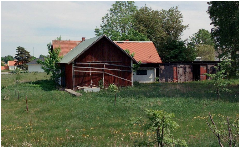
Befintlig ekonomi/ uthusbyggnad inom planområdet.
