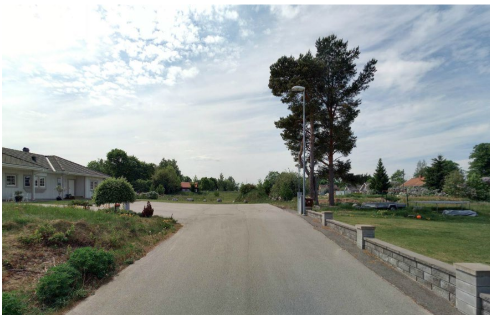
Sandtäppevägen som avslutas med en återvändsgata utgör en egen gemensamhetsanläggning (Mosås GA:10).
